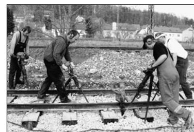
Die Kollegen aus Ettlingen unterstützten einen Tag an den elektrischen Handstopfern.
