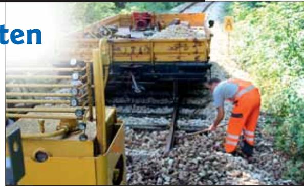
*Einzelne Schwellen werden laufend gewechselt. Dank unserem SKL ist dies auch mit wenig Personal möglich, nebenbei wird auch immer gleich Vegetationsrückschnitt auf 20 m rechts und 20 m links der Strecke betrieben.*
